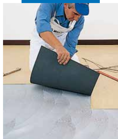
Pokládka heterogenního PVC
